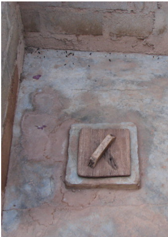
Photo 34 : Une latrine traditionnelle à pleine aire très bien maintenue.
