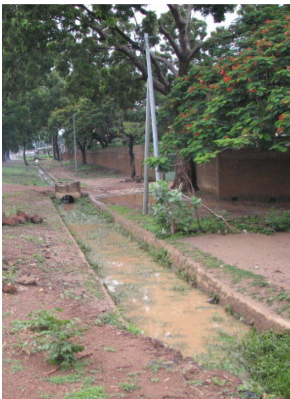
Photo 16 : Le canal d'évacuation des eaux pluviales longeant la RN4 remplis avec de l'eau après la pluie.
