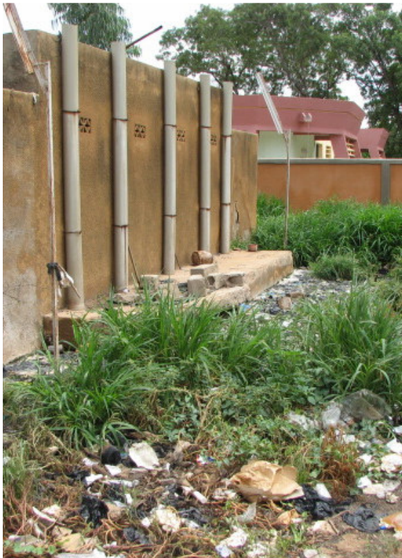
Photo 44 : Site de dépotage intermédiaire du Centre Hospitalier Régional (CHR) derrière le bloc de latrines. L'hôpital réduit de telle manière la fréquence d'appeler le camion aspiratoz.
