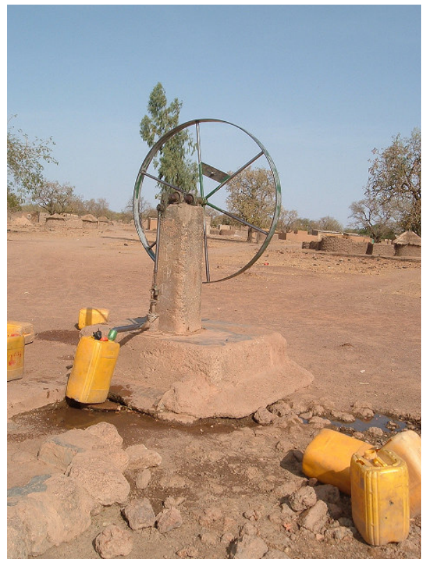
Photo 5 : Forage équipé d'une pompe manuelle (type Volanta, produite localement).
