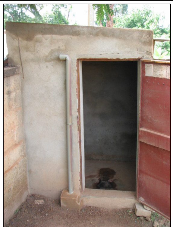
Photo 27 : Latrine VIP avec le tuyau de ventilation sur la côté de la porte d'entrée (plus fréquemment, ce tuyau se trouve sur la côté arrière de la maisonnette) et avec un trou d'accès pour vidanger à la côté arrière de la construction fermé par couvercle à soulever.
