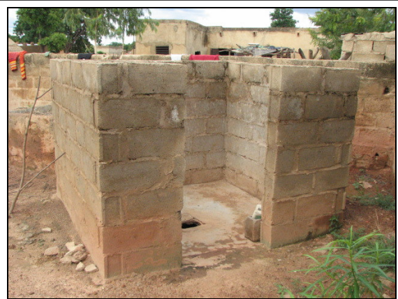
Photo 26 : Latrine traditionnelle à l'air libre avec une dalle, qui donne aucun autre accès pour vidanger que par l'agrandissement du trou existant.
