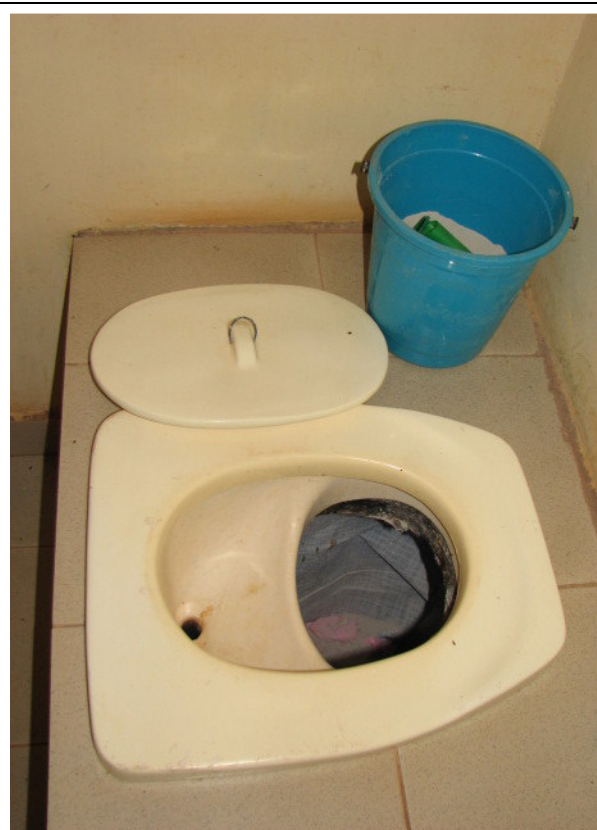
Photo 31 : La version toilette ECOSAN de position assis (modèle CREPA).
