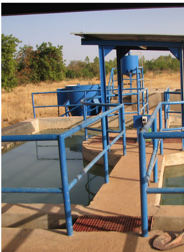
Photo 8 : Plante de purification de l'ONEA à Fada N'Gourma.
