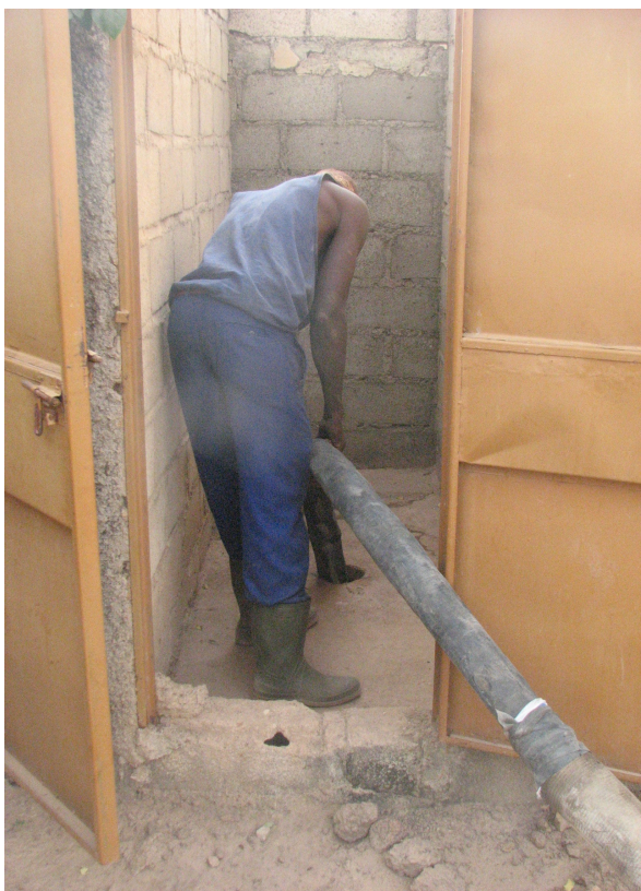
Photo 36 : La vidange mécanique, effectuée avec les tuyaux d'aspiration et les pompes hydrauliques du camion aspiré.
