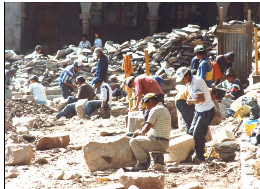
Figura 14: Obreros empleados en la restauración de la Plaza de Armas del Cusco.
