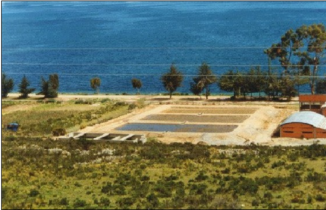
Figura 15: La planta de tratamiento en Copacabana sector Chapampa durante su construcción en agosto de 2002.
