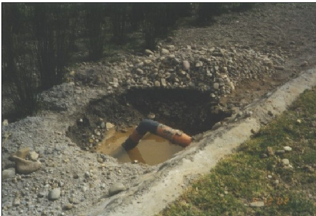
Figura 17: Pruebas hidráulicas, en la fotografía se observa el tubo de conexión al sistema principal ya reparado antes de colocar las cajas de distribución e inspección con cierre candados.
