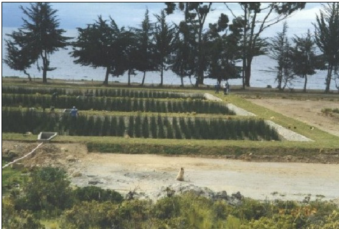
Figura 16: Visita de la planta de tratamiento justamente después la conclusión del acondicionamiento y terminación de detalles constructivos de la obra en diciembre de 2002. Algunas personas habían destruido las tuberías de conexión al sistema principal y de distribución entre las distintas celdas de purificación.
