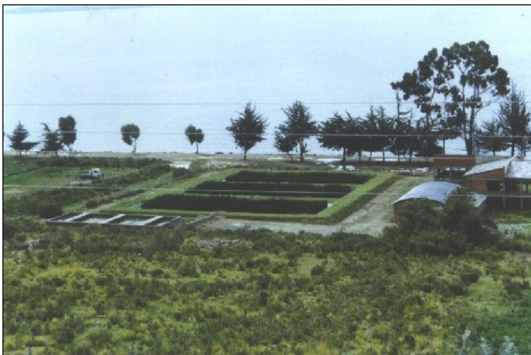
Figura 18: La planta de tratamiento después la conclusión definitiva de la obra a principios de diciembre de 2002.
